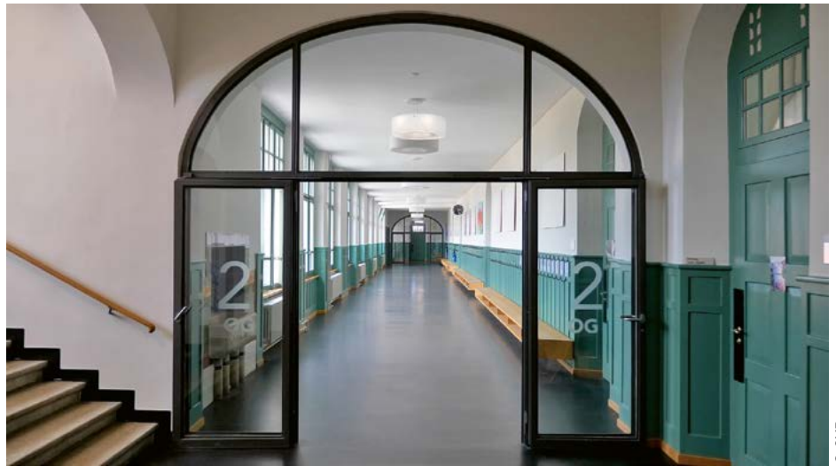
Bei Schulhäusern kann der Korridor mit den Schulzimmern als Nutzungseinheit betrachtet werden und der Fluchtweg darf über diese Raumfolge geführt werden. So lässt sich der Korridor flexibler nutzen. Im Bild das Schulhaus Pestalozzi in Thun, das noch nach den BSV 2003 saniert wurde.
